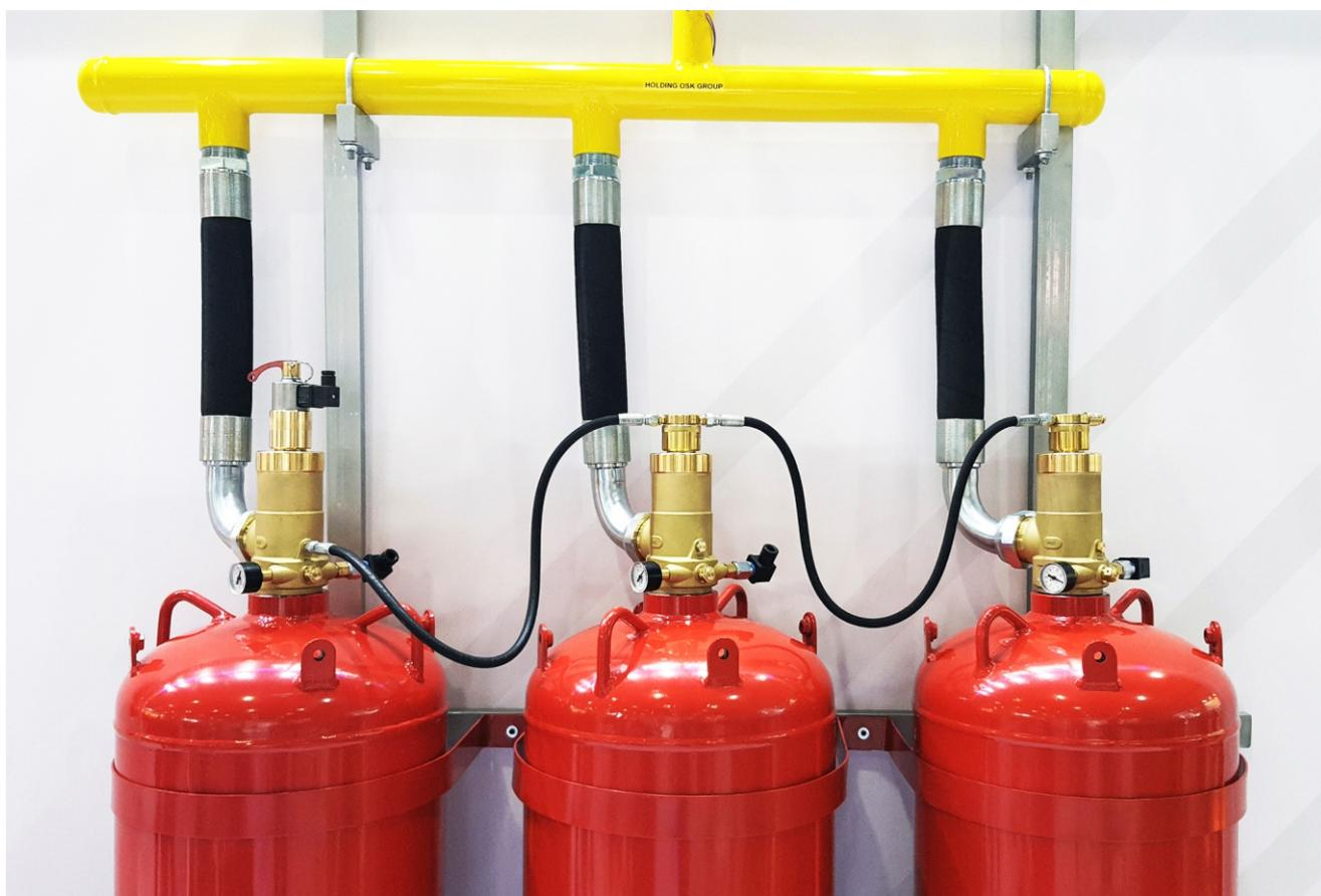
Рисунок 1 - Модули газового пожаротушения МПА-КД (50-XX-50)
